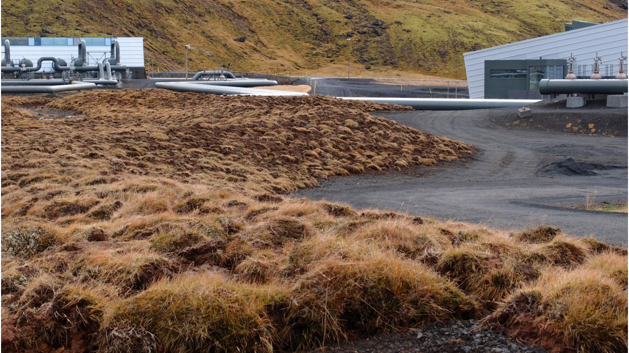
Mynd 1. Dæmi um frágang við Hellisheiðarvirkjun. Stórum gróðurtorfum sem teknar voru af nálægu mólendi var dreift yfir raskað svæði eftir landslagmótun. Þessi aðferðafræði skilar fljótt náttúrulegu yfirbragði og dregur úr skerðingu á líffræðilegri fjölbreytni.
